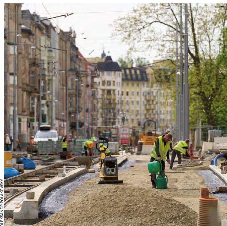
Drogowcy będą wylewać ostatnią warstwę asfaltu na Pomorskiej
